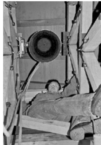
Die erste Glocke hängt schon! Ein Monteur der Fa. Perner beim Einbau.
